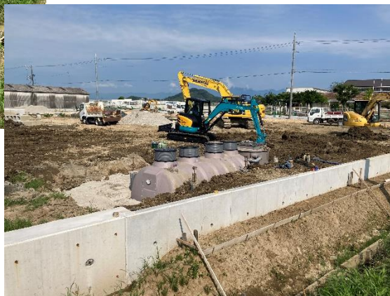
貯水槽を埋める穴が 掘られています。
